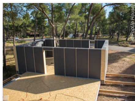
Lorsque le terrain le permet, les fondations sont réduites à leur plus simple expression.
