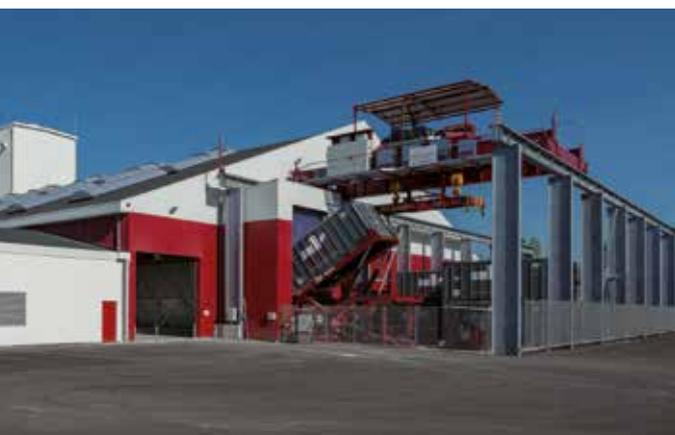
Le pont roulant assure l'alimentation du basculeur, qui permet de vidanger les conteneurs.
