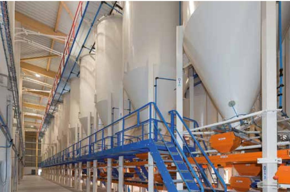
A l'intérieur, pas de broyeur. HGCT s'appuie sur un approvisionnement local, le stockage des matières premières est réparti dans 42 silos.
