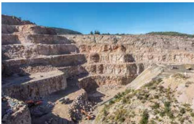
L'exploitation est faite en 6 gradins de 15 m. Le gisement est de bonne qualité, avec juste quelques zones hétérogènes à surveiller.
