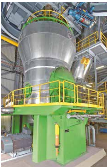
Loesche installe cinq broyeurs à ciment à Biskra.
