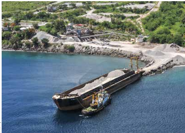
L'exportation se fait au moyen de barges de 1 700 t à 8 000 t, qui accostent sur un quai de chargement à proximité des installations de traitement.
