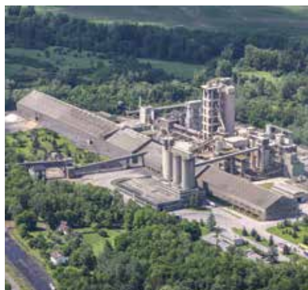
Cimenterie Vicat de Créchy, dans l'Allier.
