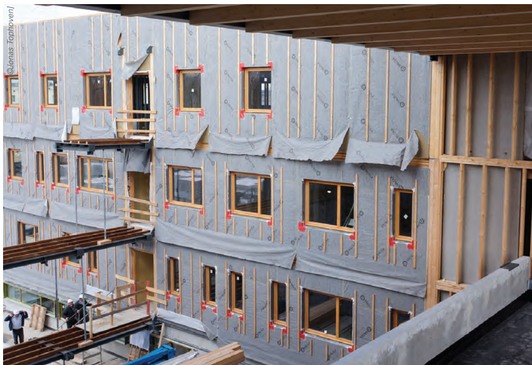
Façades des niveaux tertiaires en bois avant la pose des bardages.
