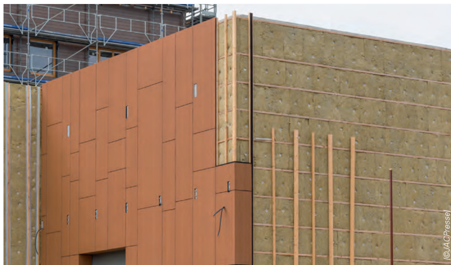
La partie du rez-de-chaussée des laboratoires et des ateliers a été isolée avec la laine de roche Rockwool et recouverte de bardages aluminium Reynobond type Corten (aspect rouillé) fixés sur ossature bois.
