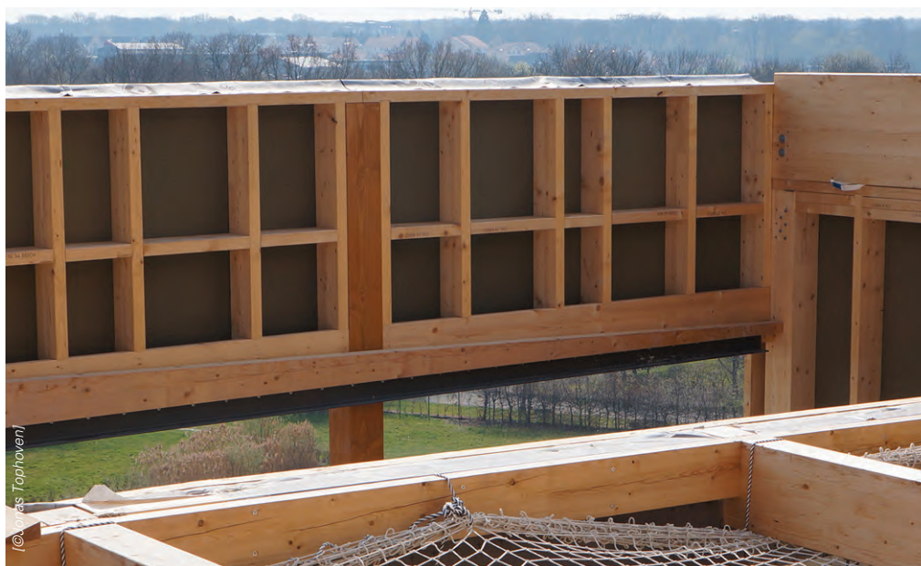
Les éléments de façade sont en ossature bois.
