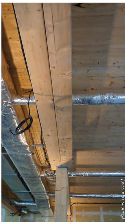
Au cœur de la solution constructive Mathis : le plancher en panneaux CLT repose sur des poutres BLC dédoublées et ajourées pour permettre le passage des gaines de ventilation.
