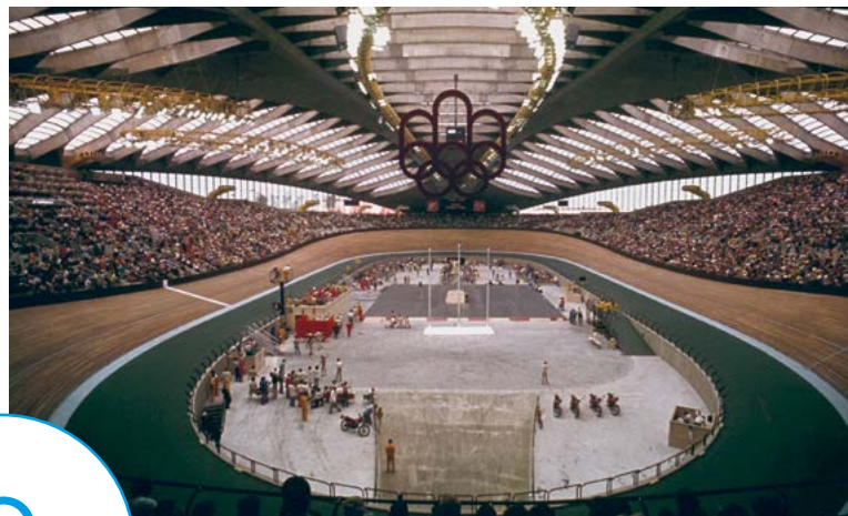
Voûte en béton précontraint du Vélodrome de Montréal (1976). Conception Roger Taillibert, Pierre Xercavins.
