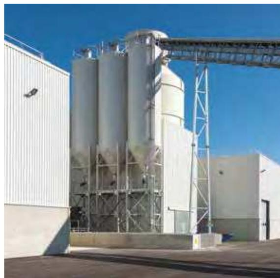
La centrale à béton a été construite par l'industriel Fameto. Elle est équipée d'un malaxeur planétaire Pemat PMP 1500.
