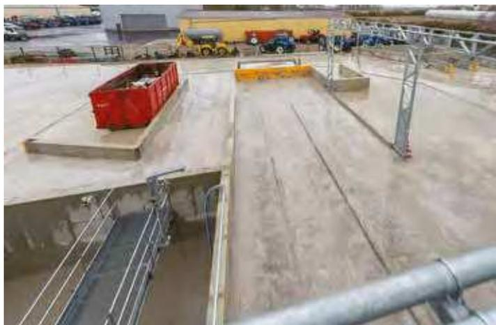
Toutes les eaux chargées sont déversées à même la plate-forme étanchéifiée en béton, appelée "plateau de lagunage".
